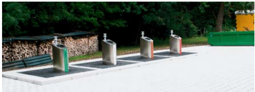
Das System der Unterflurcontainer besticht – und überzeugt die Gemeinden. Bild R. Müller
